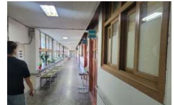
후관 1층 복도 (천정석면)
