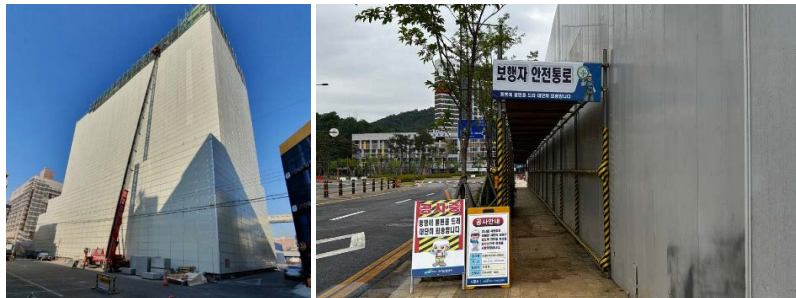
해체공사-소음방지형 판넬 설치
