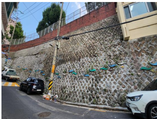
④ 북측 6m 도로 (효창원로 104길)
