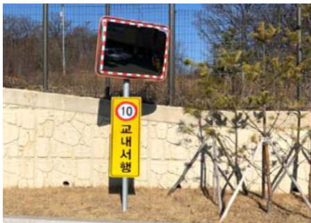
도로 반사경 설치
