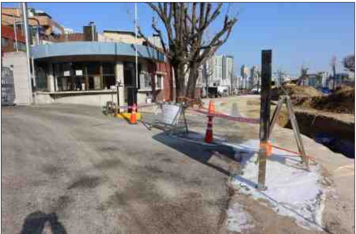
사진 3. 조사지역 서쪽 일대 시설물 전경
