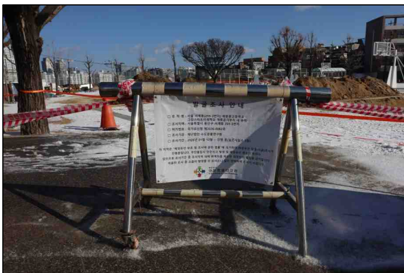
매장유산 시굴조사 안내판 설치
