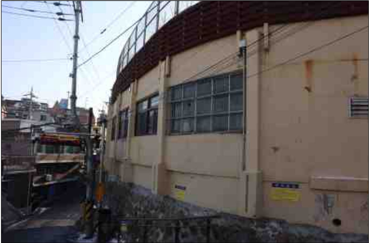
사진 6. 조사지역 북쪽 음악당(지하시설물) 전경
