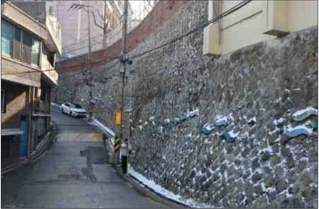
사진 4. 조사지역 북쪽 일대 견치석 옹벽 전경1
