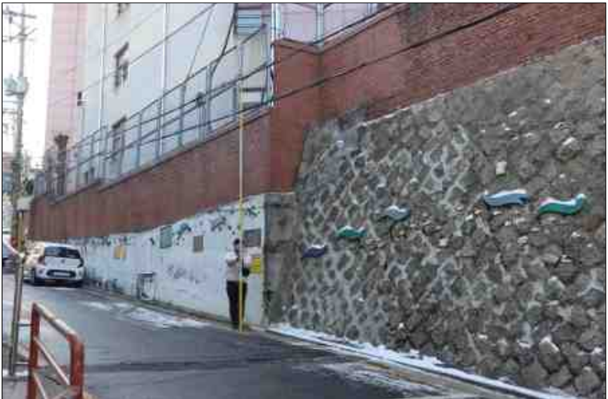
사진 5. 조사지역 북쪽 일대 견치석 옹벽 전경2
