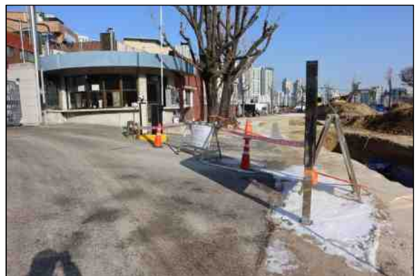
조사지역 외곽 안전띠 설치 모습1
