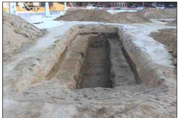
조사지역 트렌치 안전 계단식 굴토 모습
