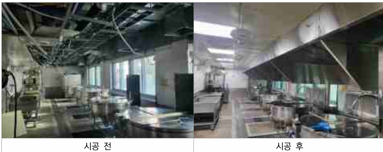
〈 사진 2. 시공 전, 후 사진 〉
