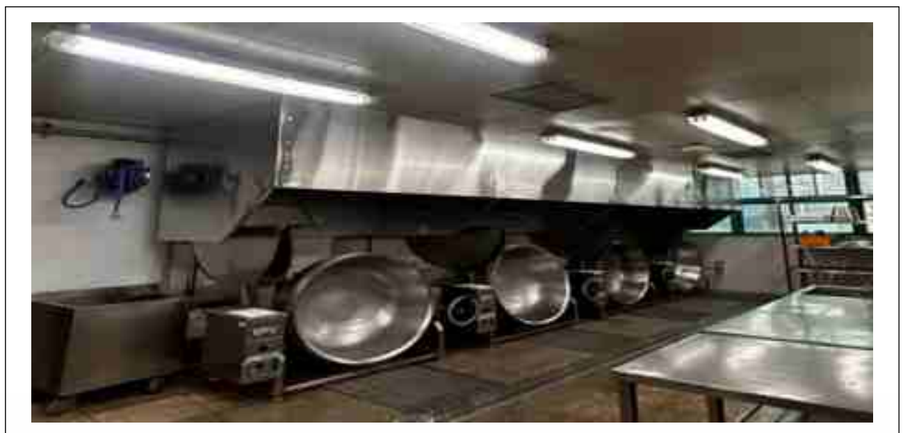
〈 사진 5. 후드(사이드패널) 설치 〉
