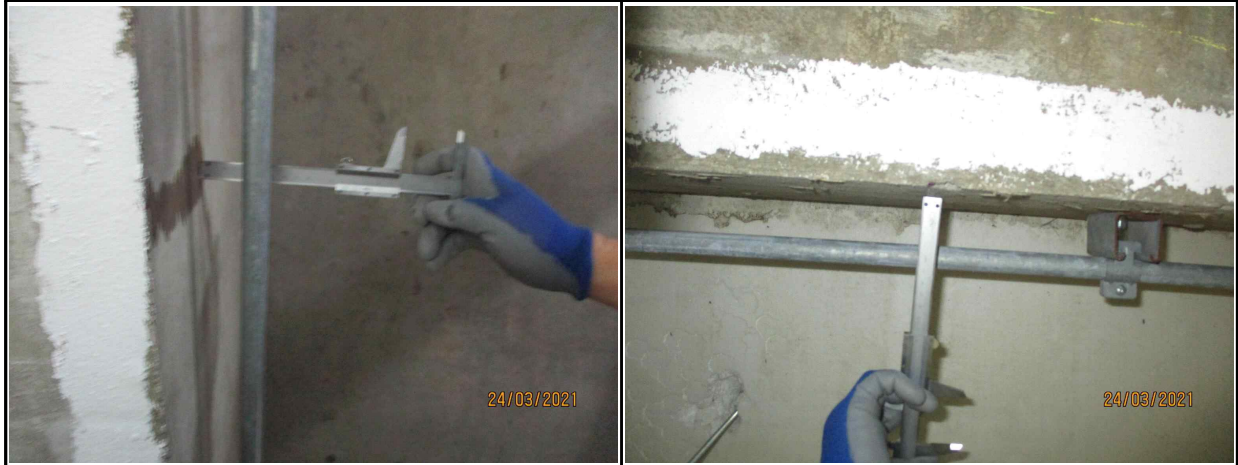
지하1층 측정 조사전경
