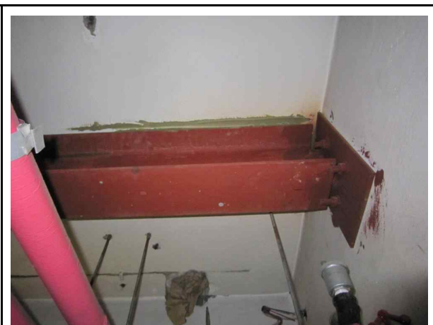
상부 철골 빔 보강 현황
