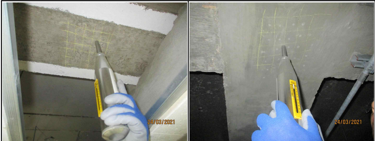
지하1층 측정 조사전경
