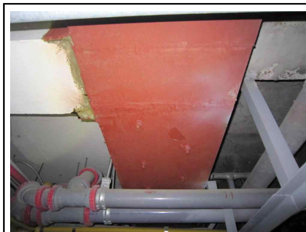
상부 보 철판 보강 현황
