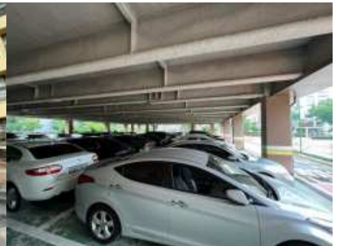
무지개관 하부 필로티 주차장
