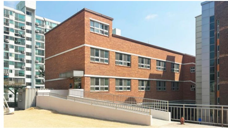
7. 선덕중 급식실 및 교사동(증축 대상 건물)
