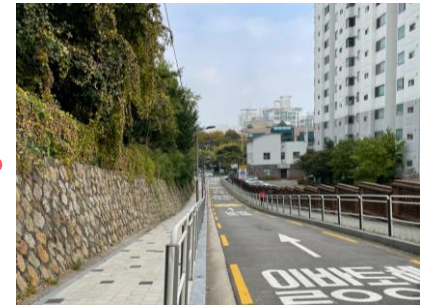
대상지 주위 옹벽
