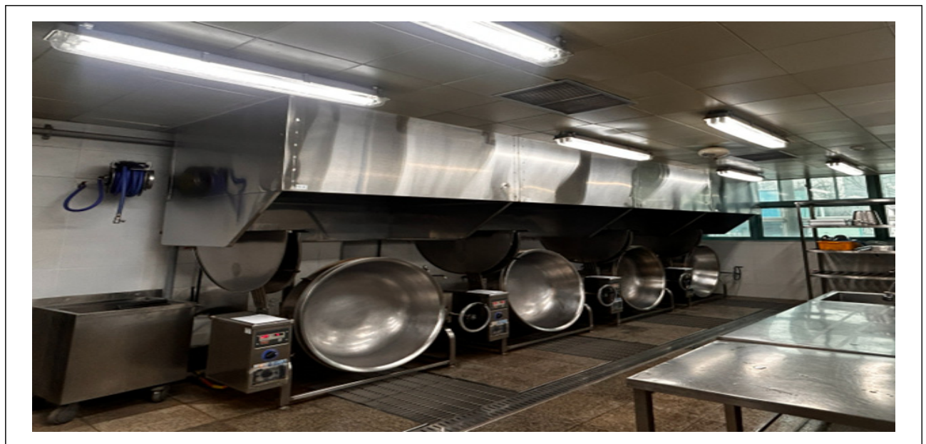
〈 사진 5. 후드(사이드패널) 설치 〉
