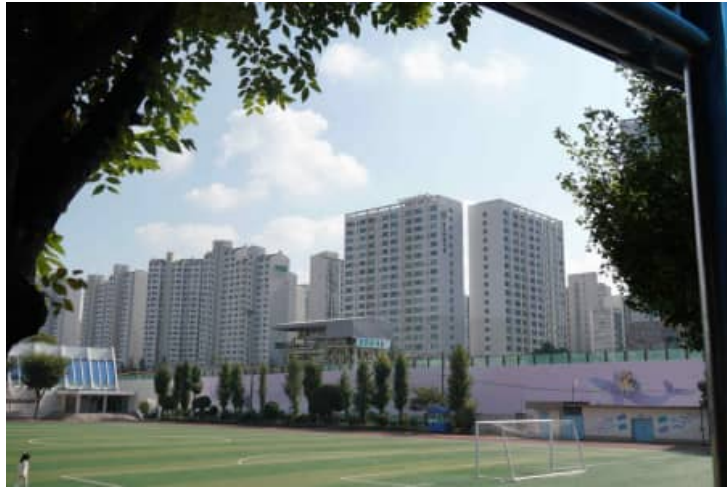
학교 대지 남쪽 고층아파트와 신안산선 공사부지
