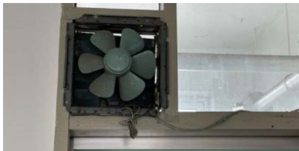
〈그림 2-16〉 방치된 노후 공기 순환 시스템
